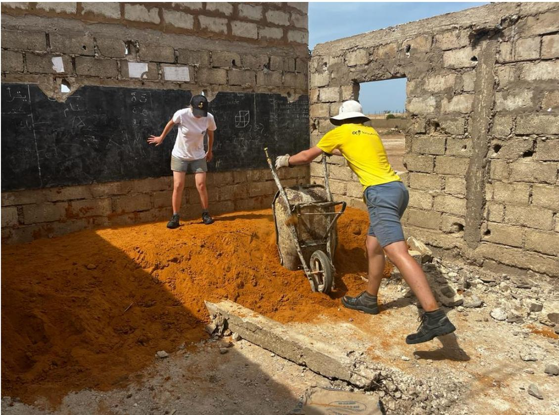
Fig. 3 Remblayage de la salle
